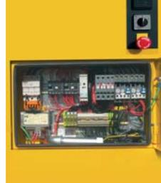
Armoire électrique, entièrement câblée, tableau de commande avec compteur horaire et commutateur-sélecteur de mode de fonctionnement
