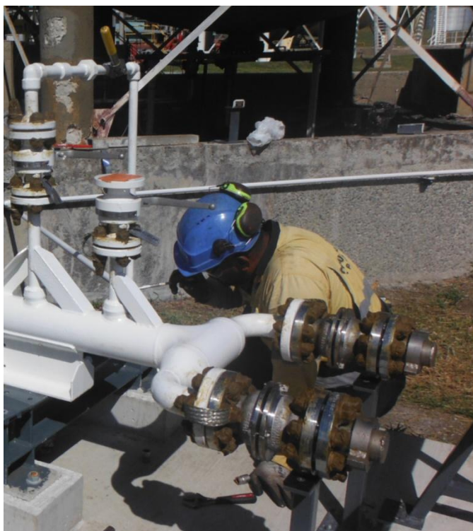
Figure 20 : Raccordement des flexibles au niveau de la pomperie 1
