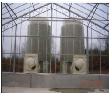
Extracteur d'air à biofiltre
