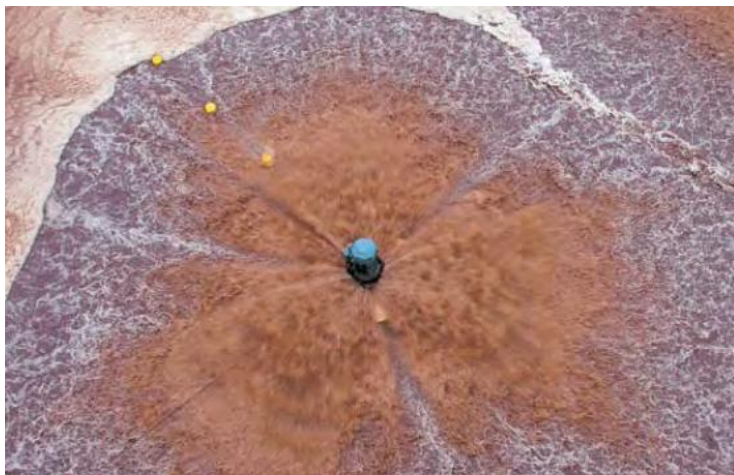
Turbine flottante d'aération en fonctionnement
