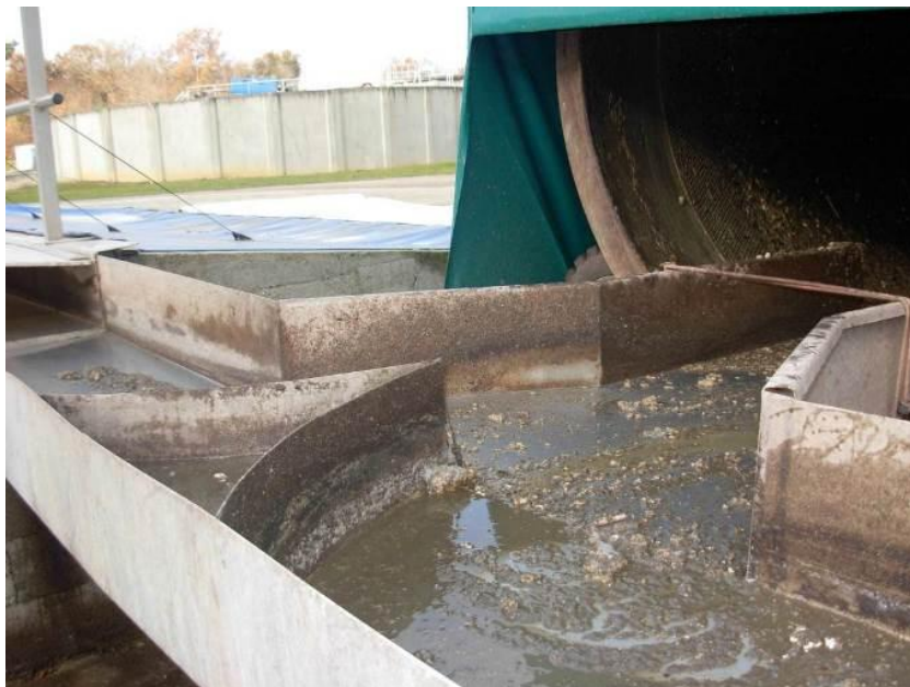
Chenaux d'alimentation du tamis dégrilleur
