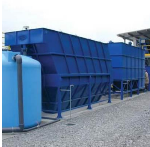
Exemple de décanteur lamellaire
