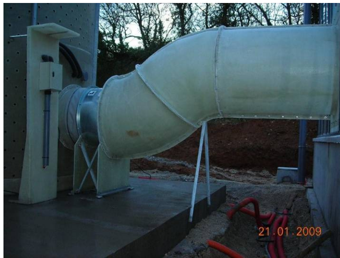
Ensemble gaine / extracteur pour une serre de séchage solaire
