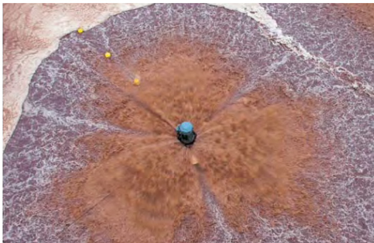
Turbine flottante d'aération en fonctionnement
