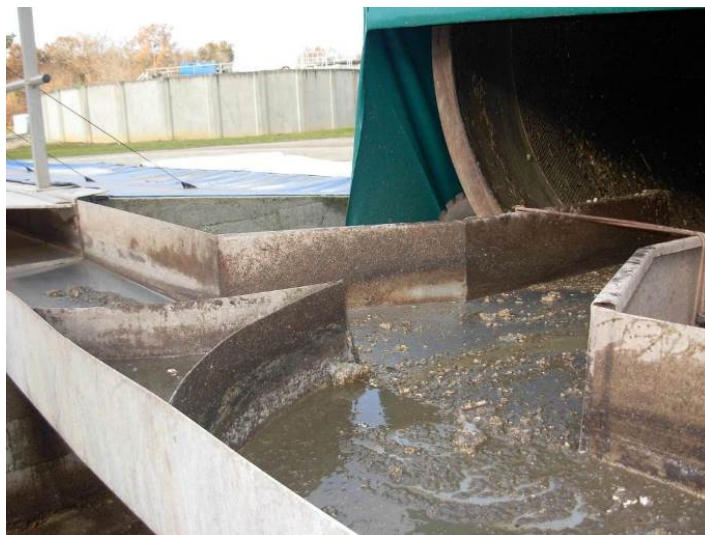
Chenaux d'alimentation du tamis dégrilleur
