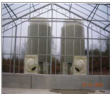
Extracteur d'air à biofiltre
