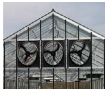
Ventilateur muraux (Extracteur d'air)
