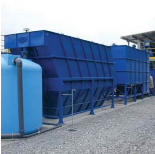
Exemple de décanteur lamellaire
