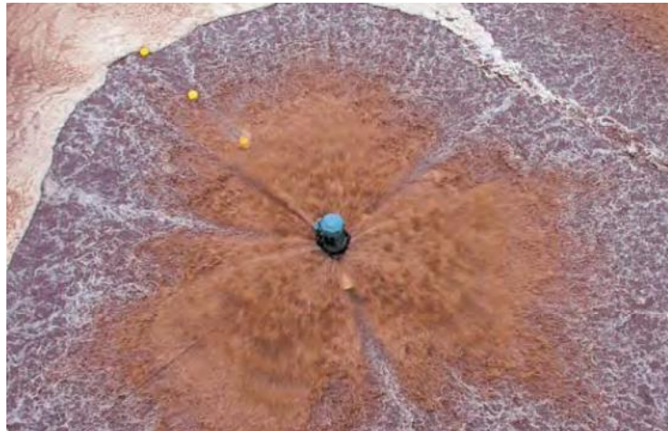
Turbine flottante d'aération en fonctionnement
