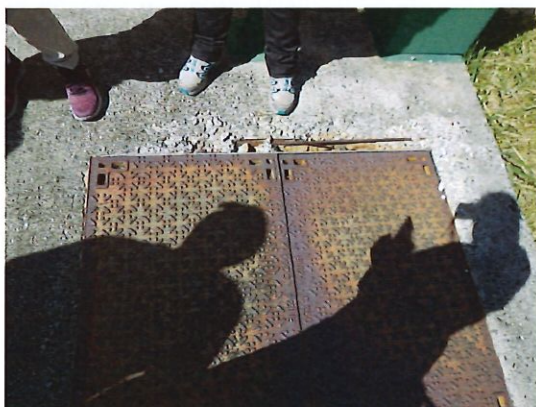
Photo 3 : regard du poste de refoulement endommagé
