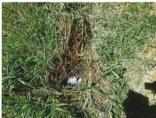
Photo 4 : tuyau cassé (lit d'infiltration)
