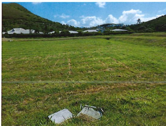
Photo 2 : regard endommagé (vannes du lit d'infiltration)
