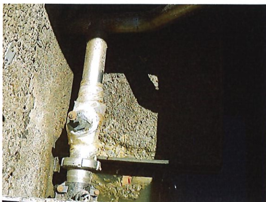
Photo 7 : fuite d'air sur vanne d'injection
