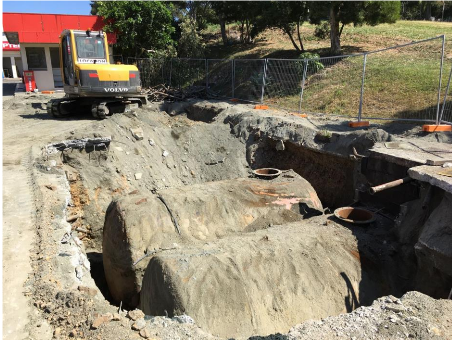
Figure 47 : Excavation des cuves enterrées de SP (03/10/16)
