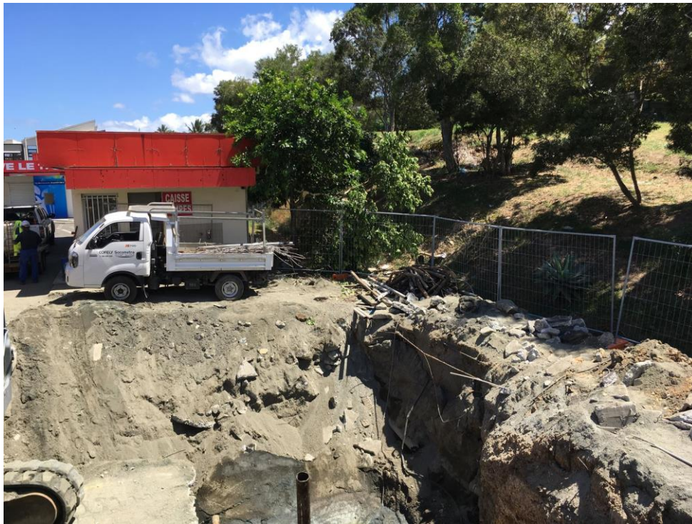
Figure 49 : Fouilles après retrait de deux cuves GO et SP (28/09/16)
