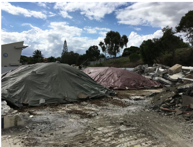
Figure 53 : Andains couverts de stockage provisoire des terres excavées par la DEPS (28/10/16)
