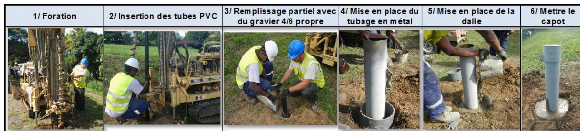
Figure 25 : Phasage de la pose d'un piézomètre par A2EP
