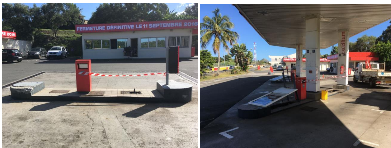
Figure 46 : Suppression des pompes de distribution
