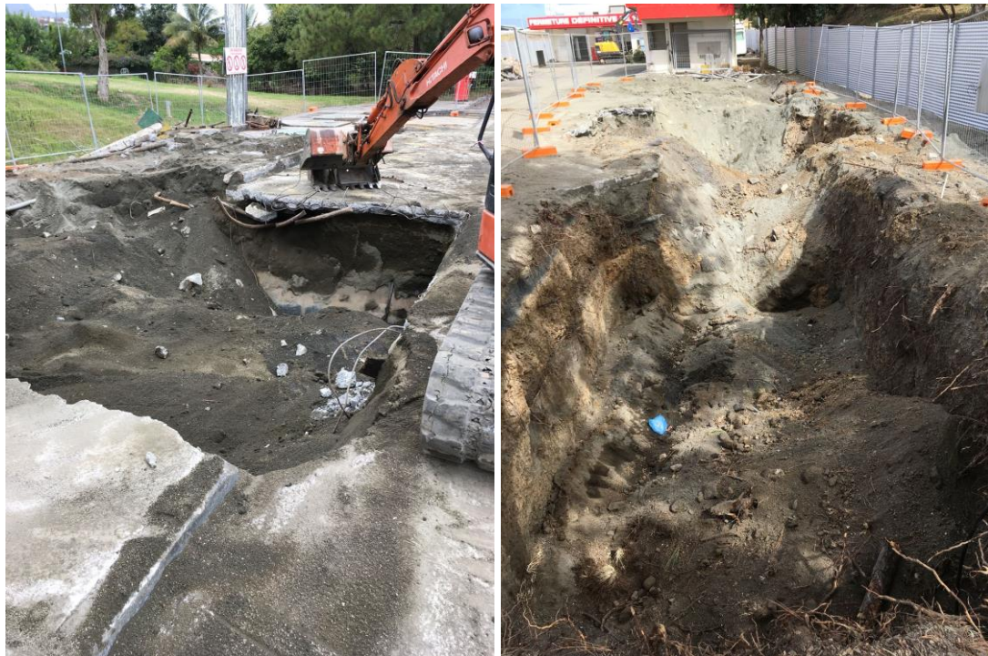
Figure 48 : Fouilles après excavation des cuves enterrées (07/12/16)
