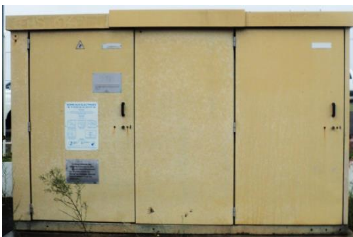
Figure 4 : Transformateur HT/BT
