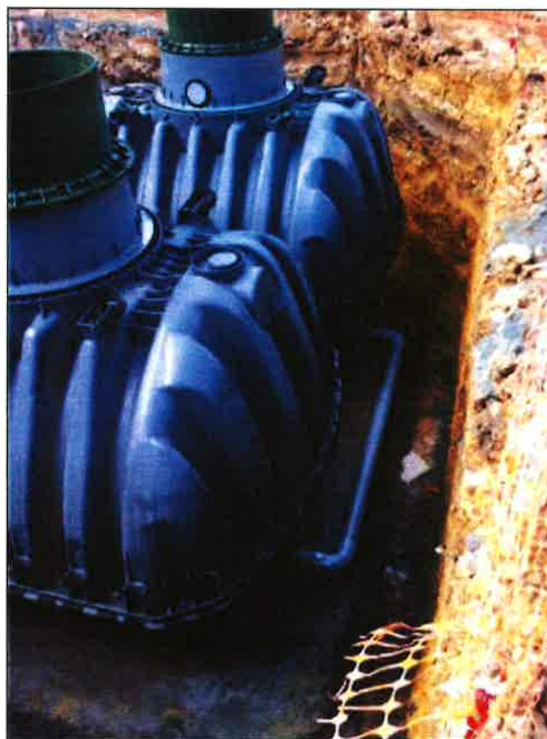
Station d'épuration KLARO 44EH Cuves Carat sur la commune du Mont Dore
