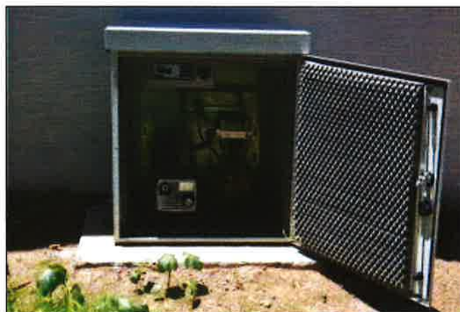
Exemple d'armoire de pilotage externe
