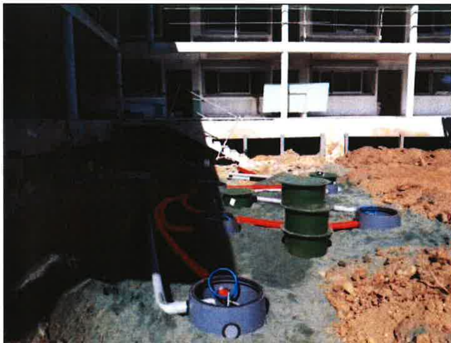
Station d'épuration KLARO 67 EH Cuves GRAF Commune de DUMBEA
