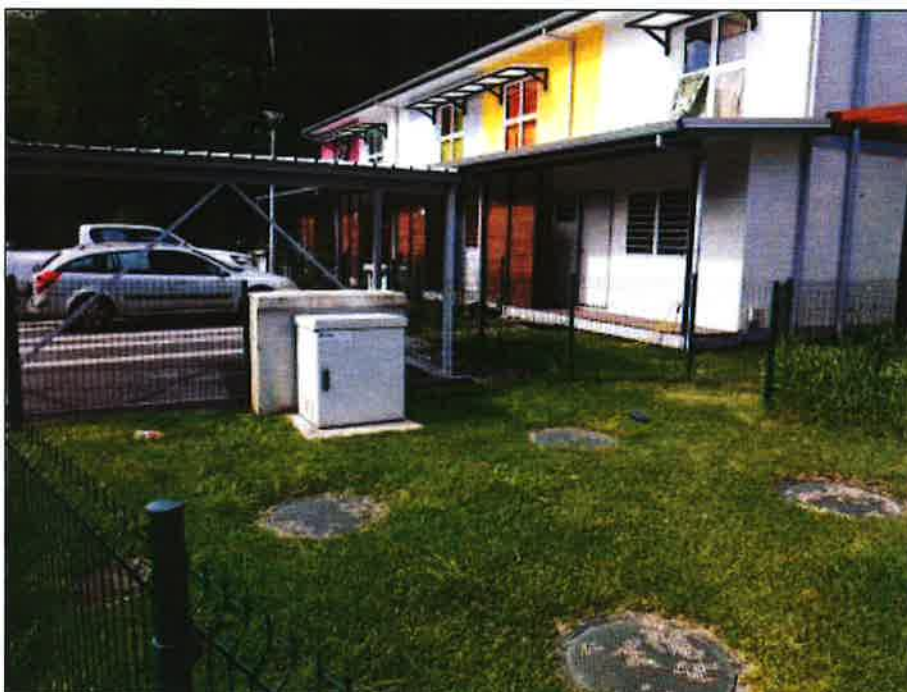
Station d'épuration KLARO 44H Cuves Carat - Commune du Mont Dore
