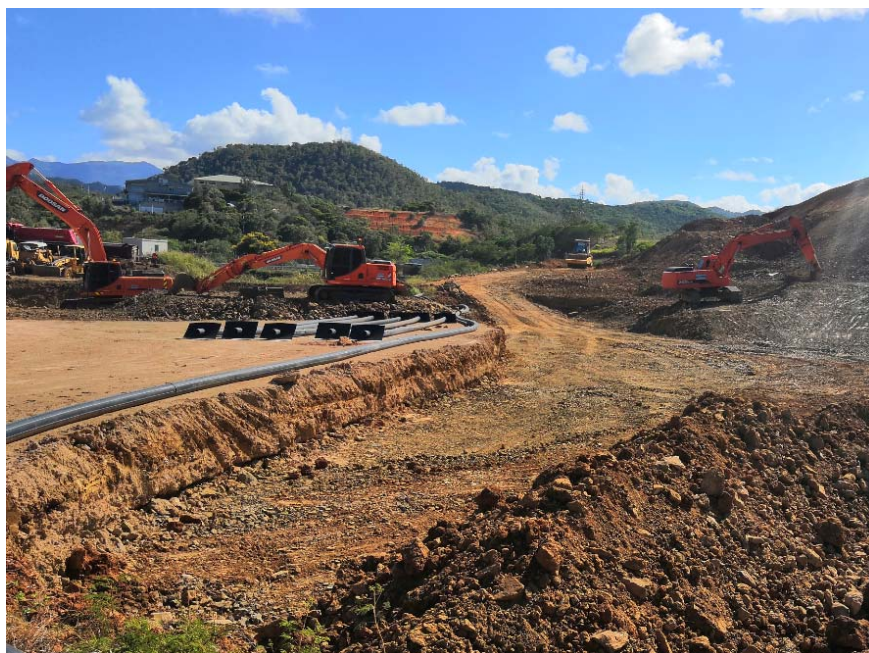
Pose des traversées sous digue intermédiaire F1/F2 au 16/01/2019
