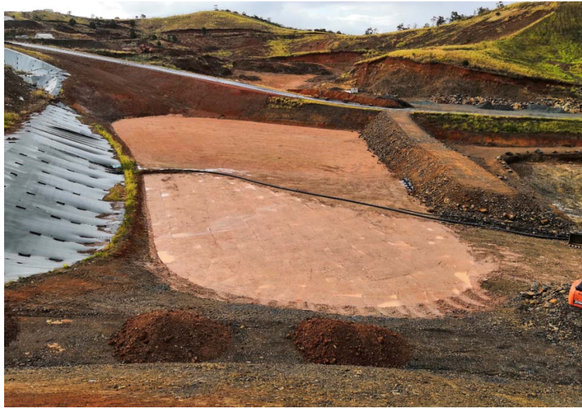
Figure 5 : remblaiement de la digue intermédiaire F1/F2 et fond de casier F1 au 29/01/2019
