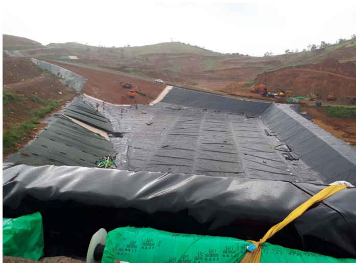
Figure 7 : pose de la géomembrane au 07/03/2019
