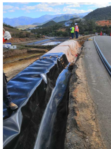
Figure 8 : pose de la clé d'ancrage au 13/02/2019
