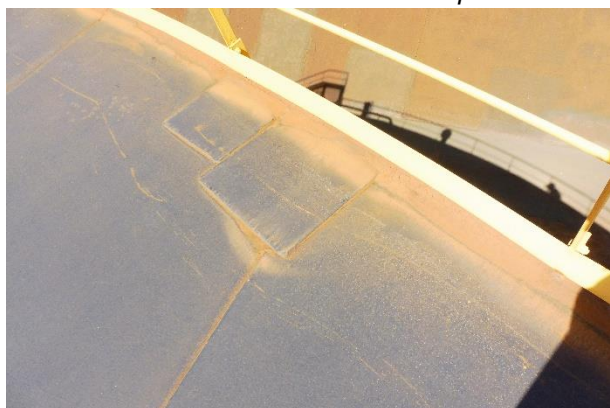
Exemple de doublage sur tôle de toit.
