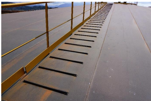
Plinthe dessoudée et profilé soudés sur toit
