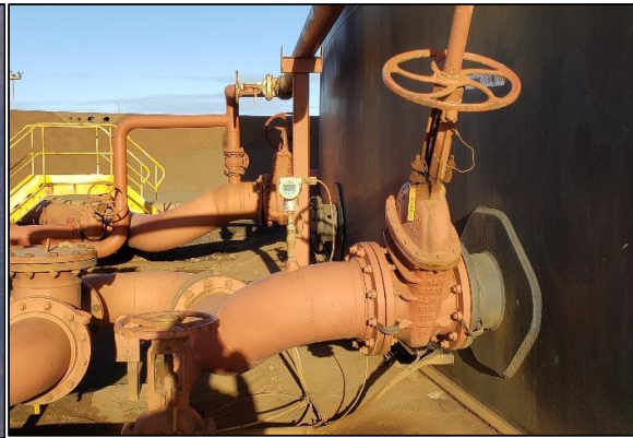
Figure 4: Vanne N5 après réparation
