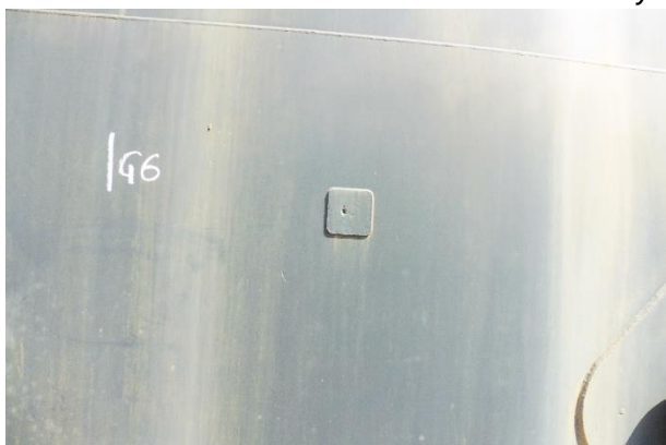
Ancienne tôle martyre de support perforée
