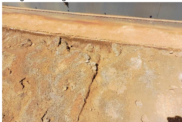
Dégradation du joint solin / réservoir et dégradation légère du solin.
