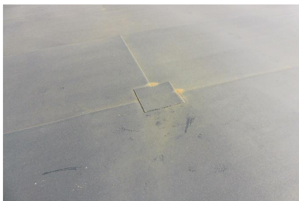
Exemple de doublage sur tôle de toit.
