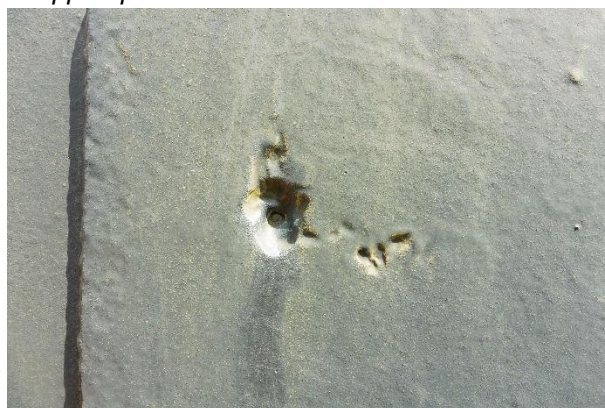
Ancienne tôle martyre de support perforée
