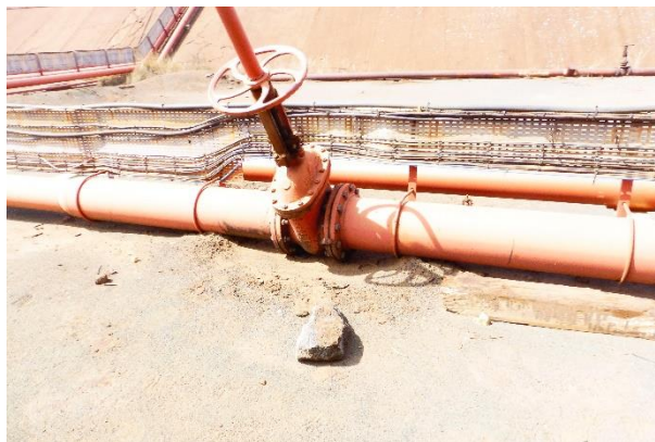
Vanne contre le sol et tuyauterie non utilisée.
