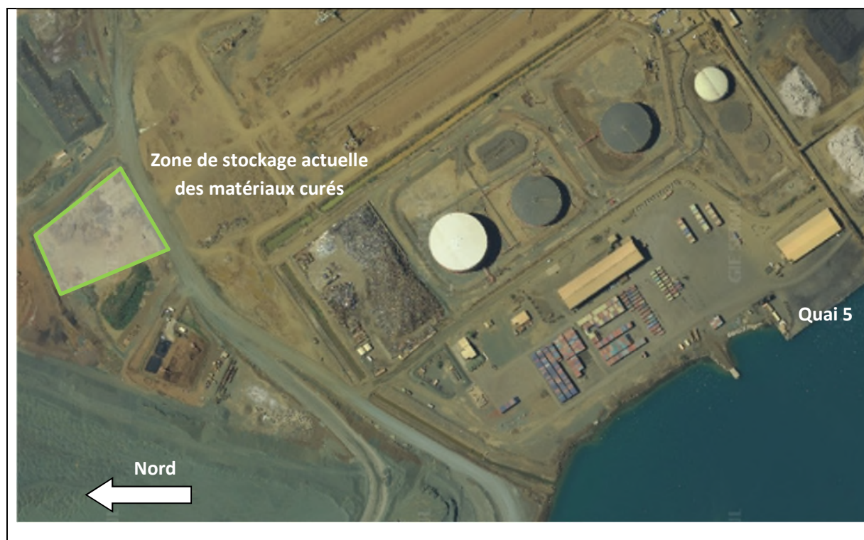
Localisation de la zone de stockage des matériaux curés
