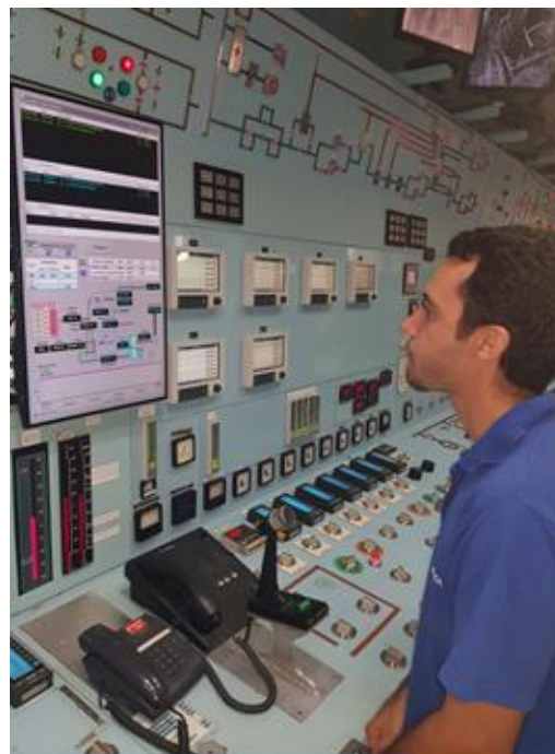
Photo 5 : Opérateur pilotant la charge d'une tranche de la Centrale, en fonction de l'outil d'optimisation pilotage
