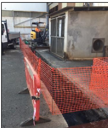
Photo 2 : Séparation des réseaux EP / EI
