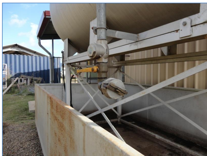
Figure 16 : Raccord de dépotage
