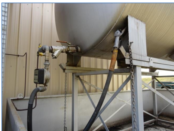
Vanne d'arrivée extérieure
