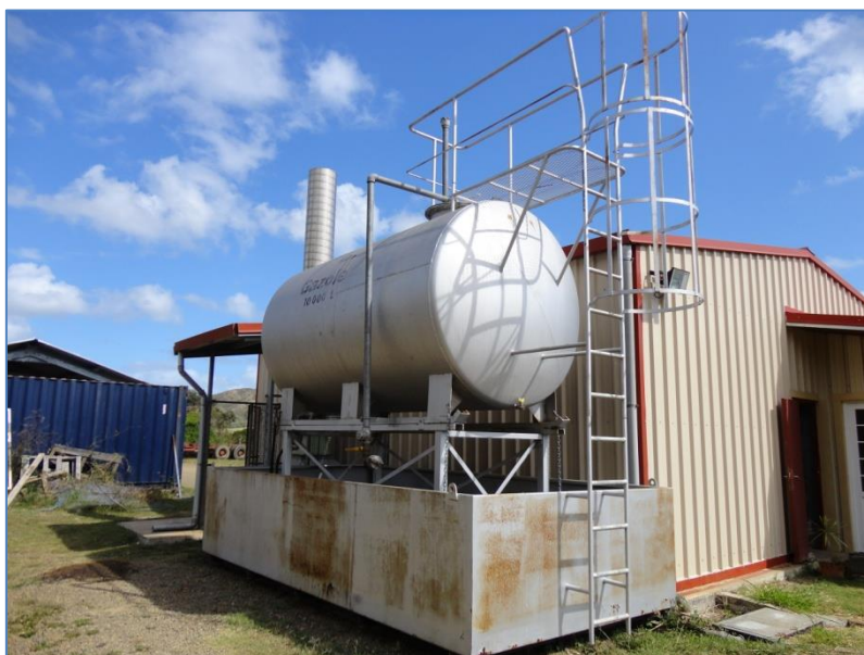
Figure 15 : Cuve de gazole sur bac de rétention
