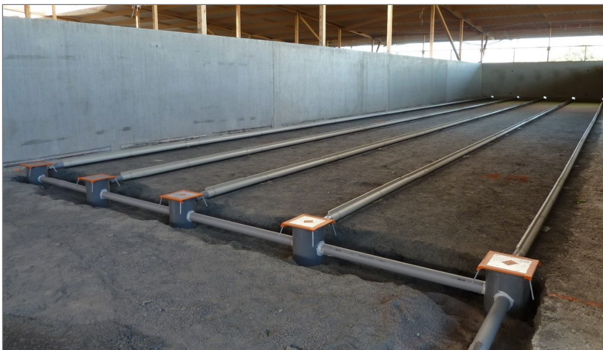
Figure 8 : Pots-de-garde avant coulage de la dalle béton
