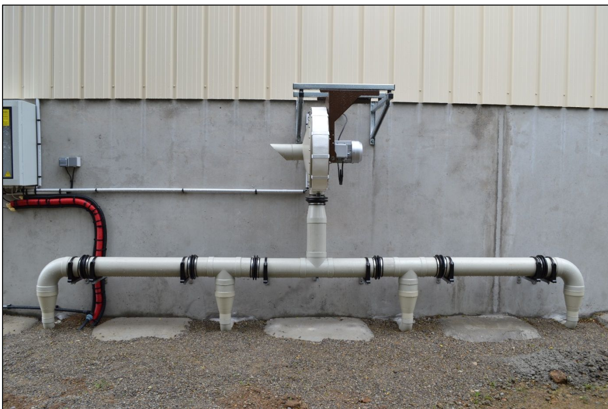
Figure 7 : Ventilateur et collecteur d'air
