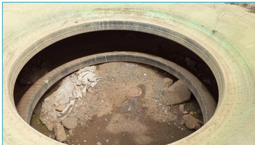
Figure 5: piézomètre P8 (source: EMR, 2020).
