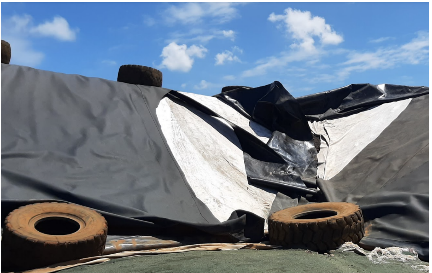
Photo 3 : Alvéole n°28 d'entreposage temporaire de scories calcosodiques suite au passage du cyclone NIRAN
