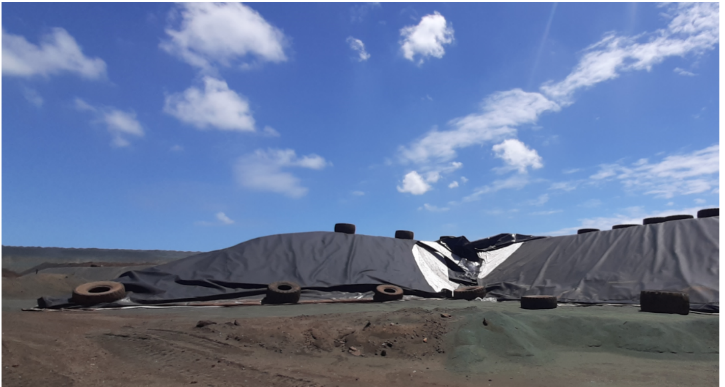
Photo 2 : Alvéole n°28 d'entreposage temporaire de scories calcosodiques suite au passage du cyclone NIRAN
