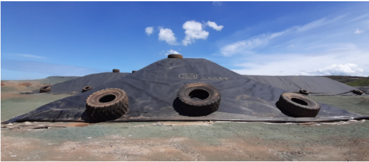
Photo 8 : Extrémité Ouest de l'alvéole n°29 – Réparation de la géomembrane par TERRA NC
