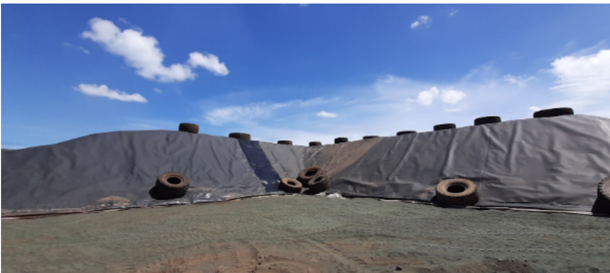
Photo 7 : Jonction entre les alvéoles n°28 et n°29 – Réparation de la géomembrane par TERRA NC
