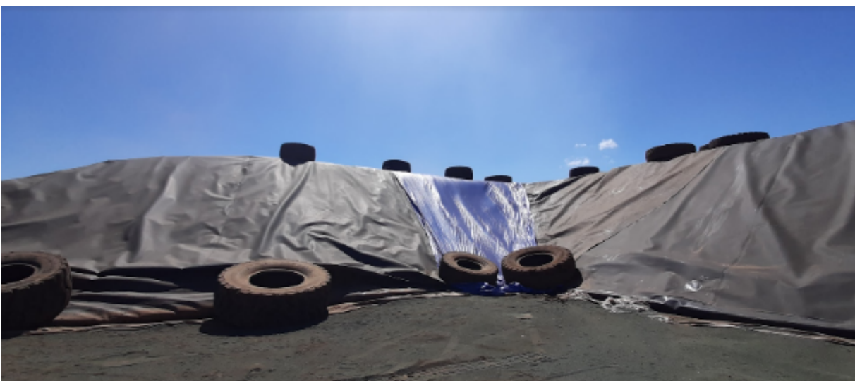
Photo 4 : Jonction entre les alvéoles n°28 et n°29 – Pose d'une bâche de protection par les équipes SLN
