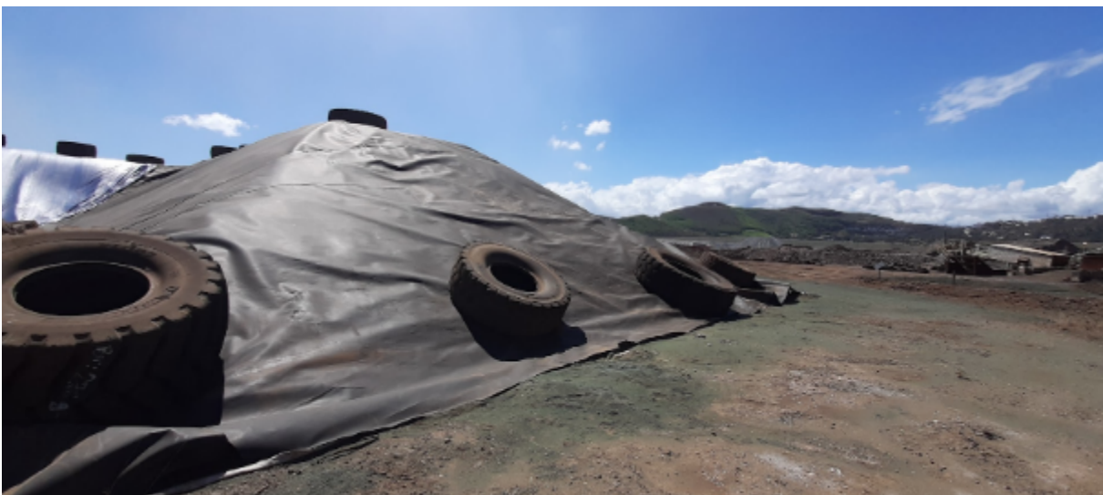
Photo 6 : Extrémité Ouest de l'alvéole n°29 – Remise en place de la géomembrane par les équipes SLN
