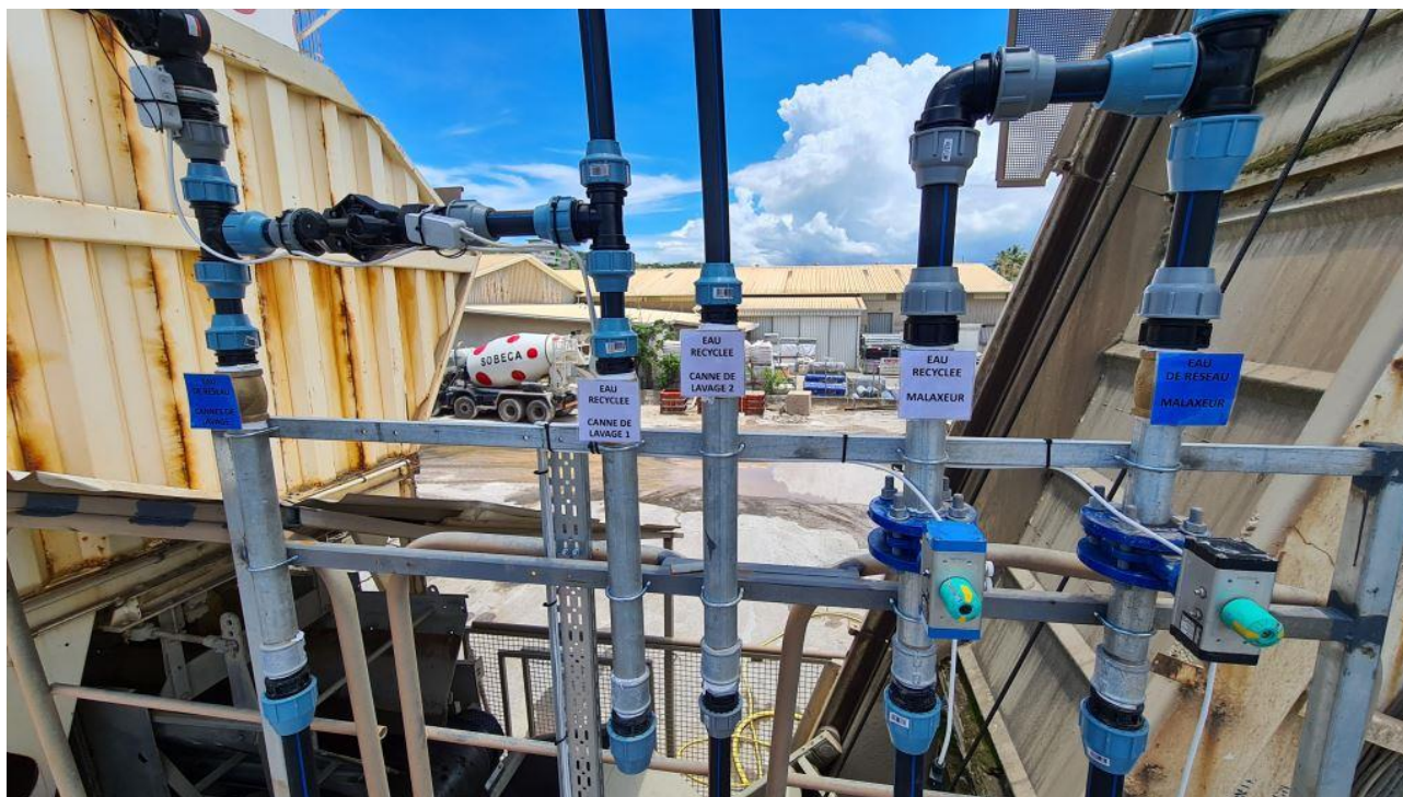
Figure 10 : Système automatisé de recyclage de l'eau pour le lavage des camions malaxeur, le lavage du malaxeur et la fabrication de béton
