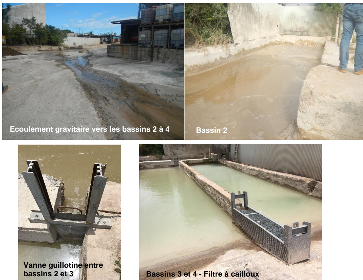
Figure 10 : Eléments de gestion des eaux existants sur le BV2
