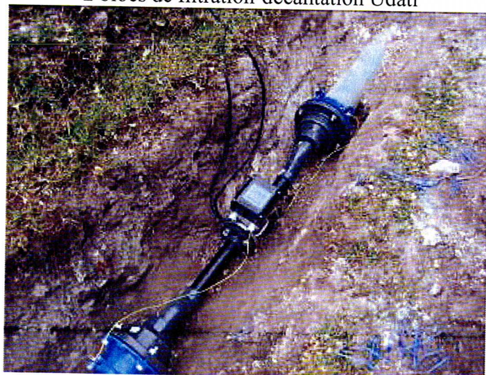
Débitmètre de sortie STEP
