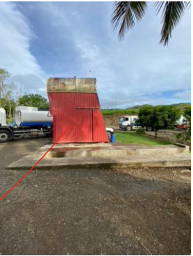
Dock servant au stockage des Futs d'huile avec cuve de 13,5m3 en partie haute
