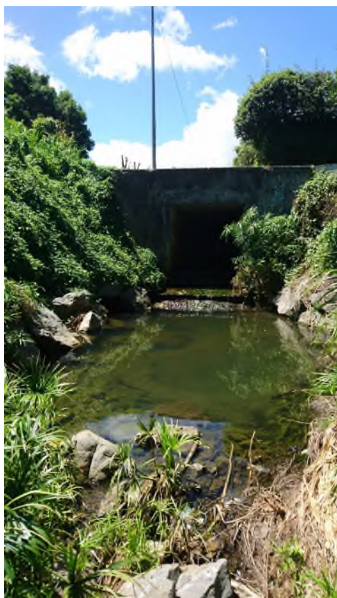
Figure 2 : sortie arroyo (point amont) et ouvrage cadre sous la voie express (point aval 1)
