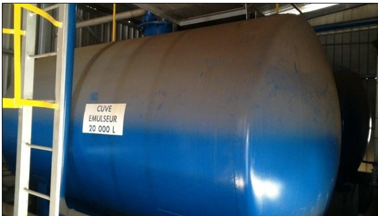
Figure 38 : Cuves d'émulseurs
