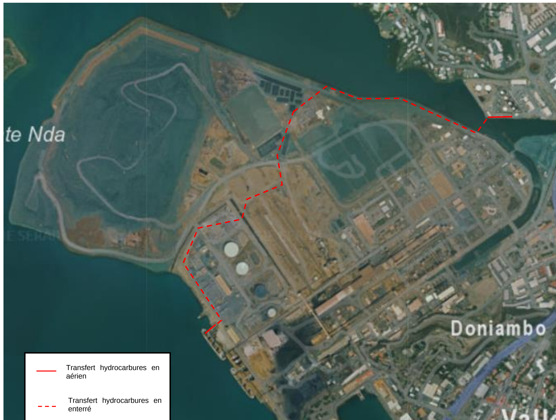
Figure 82 : Potentiels de dangers liés à la canalisation de dépotage hydrocarbures
