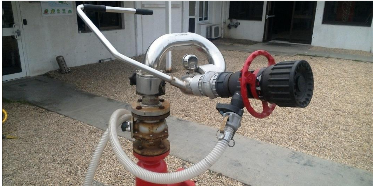
Figure 56 : Canons fixes du dépôt de Ducos
