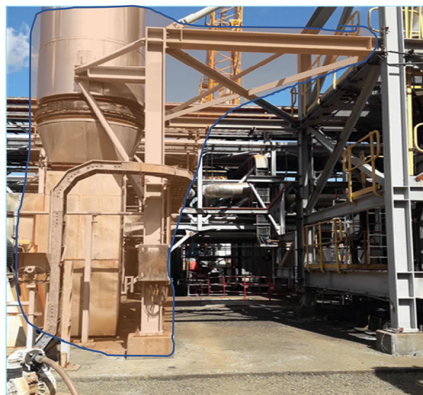
Conduit de la cheminée 1, booster et structure vers venturi à démanteler
