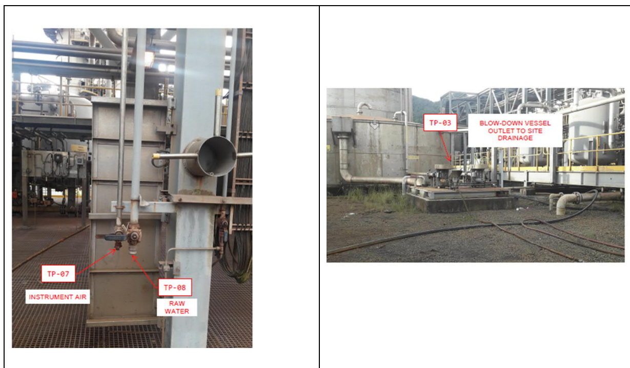
Figure 10 : Photos des points de connexion aux réseaux air et eau
