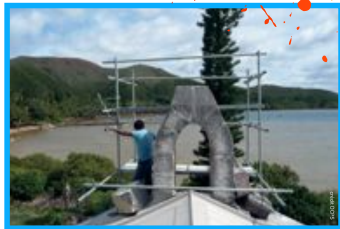
Les travaux de restauration de l'Eglise d'Ouara à l'île Ouen ont été réalisés avec le soutien de mécènes
