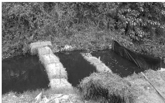
Exemple de barrière à sédiment à ballots de paille suivi d'une barrière à géotextile.
