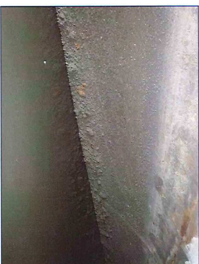
Photo n°15 : Hauteur de marnage importante + envasement + algues et boue collé sur paroi intérieur tube
