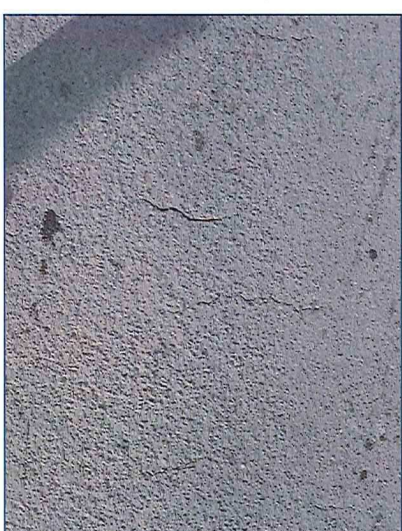
Photo n°8: Fissure chaussée – côté amont
