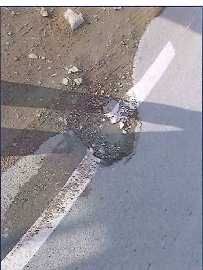
Photo n°9: Déformation chaussée en rive – formation de trou/orniérage-
