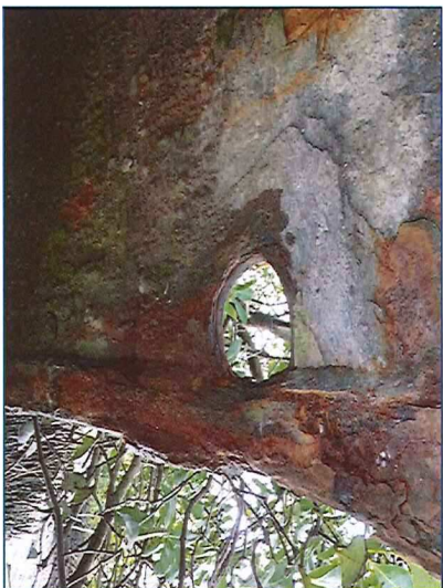
Photo n°16 : Corrosion totale, déformation et tête de buse percée côté aval
