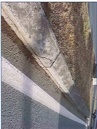
Photo n°10 : Eclat/fissuration – altération de surface bordure terre-plein central
