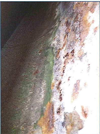
Photo n°17 : Tube intérieur totalement corrodé, feuilletage, perte de section significative, hauteur de marnage importante et présence d'algues et boue collée sur les parois inférieures des tubes
