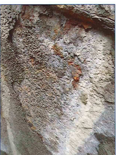
Photo n°14 : Tube intérieur totalement corrodé, feuilletage, décollement par plaque, perte de section significative
