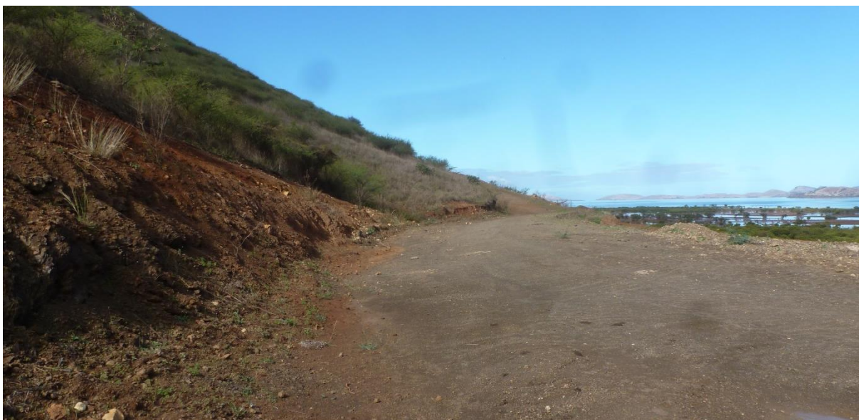
Figure 1: dévers transversal et piste rechargée de schiste (SMGM, novembre 2015)
