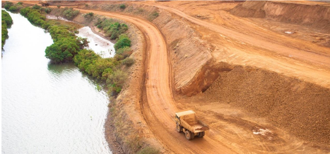
Figure 3: merlon étanche qui borde la piste le long du front de mer pour éviter les débordements (SMGM, novembre 2015)
