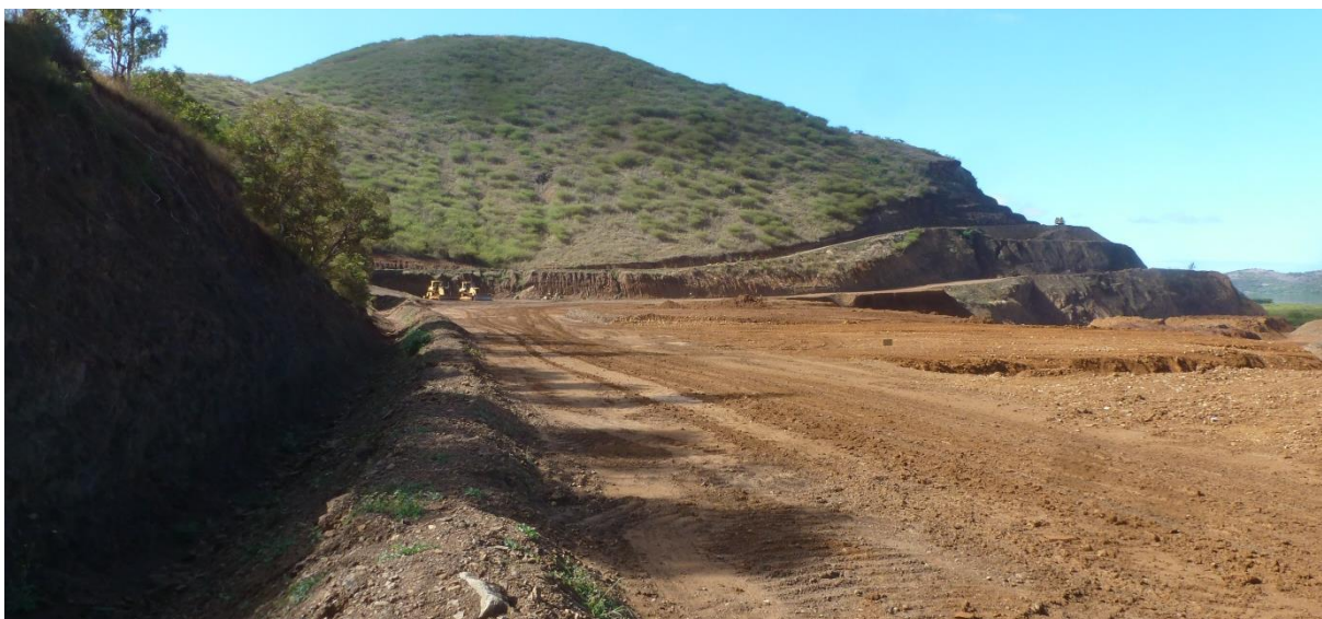
Figure 2: merlon étanche isolant le cavalier à droite de la plateforme de bennage à gauche (SMGM, novembre 2015)
