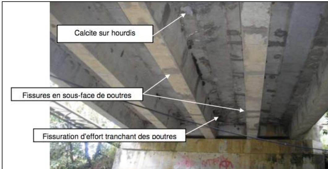
Figure 11 : vue des fissurations d'effort a niveau du tablier (source : DEPS, 2016).
