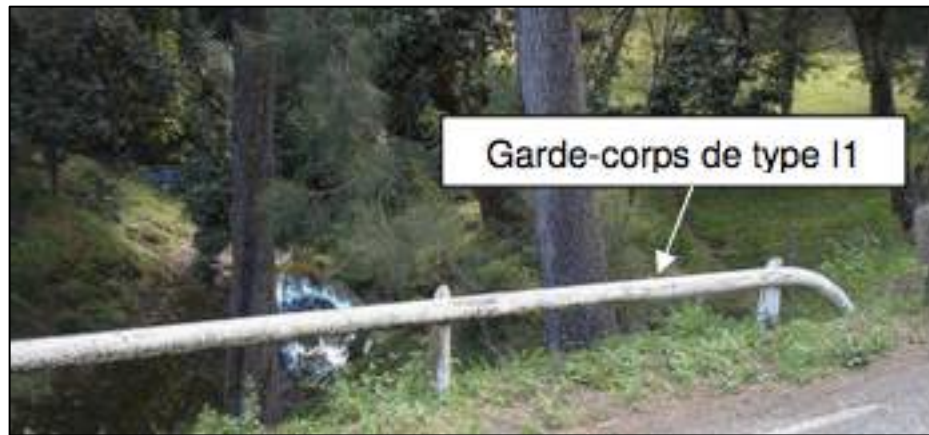
Figure 6 : vue des garde-corps de type I1 sur l'ouvrage Fiori (source : DEPS, 2016).
