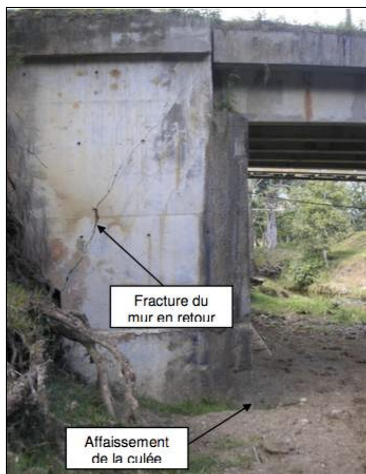
Figure 10 : vue des détériorations du mur et de l'affaissement de l'extrémité amont de la culée rive gauche de l'ouvrage Fiori (source : DEPS, 2016).
