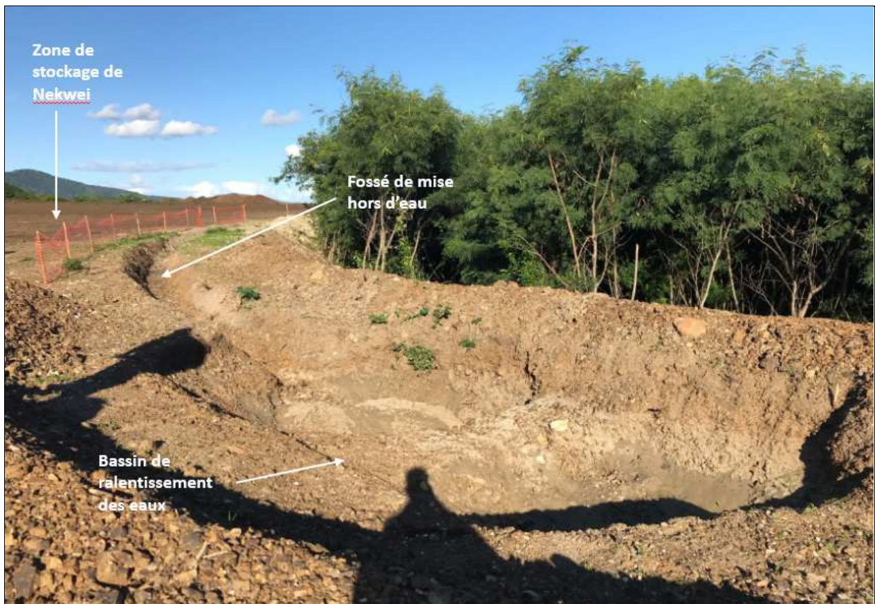
Figure 3 : Exemple de fossé de mise hors d'eau et de bassin de ralentissement des eaux mis en place en bordure de la plateforme de stockage de Nekwei - Source : EMR, 2018
