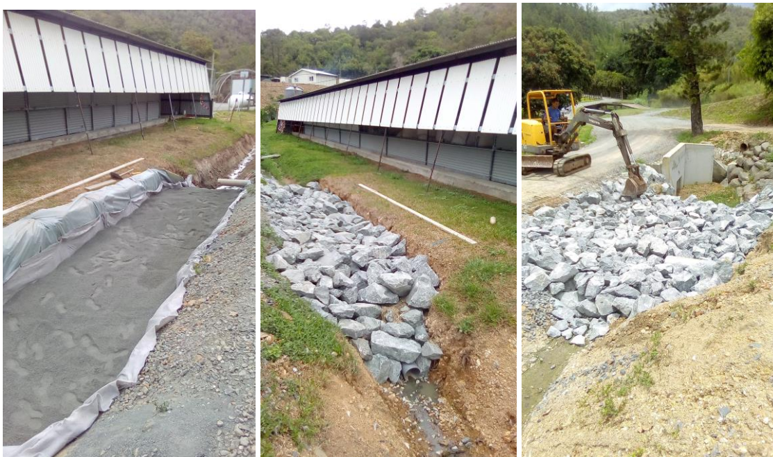
Figure 23 : Filtres à sable - Photos : Patrick Fayard, 2018
