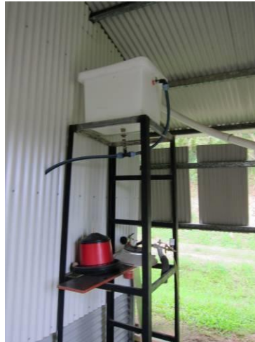
Figure 19 : Petit réservoir à flotteur – Photo Soproner
