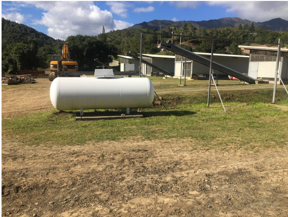
Figure 17 : Cuve de gaz
