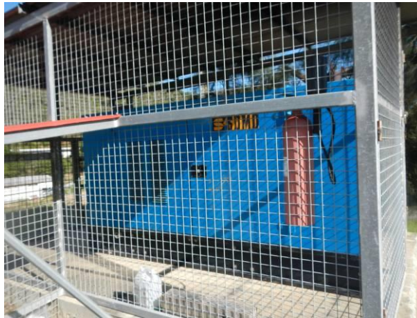
Figure 21 : Groupe électrogène 200 KVA - Photo Soproner
