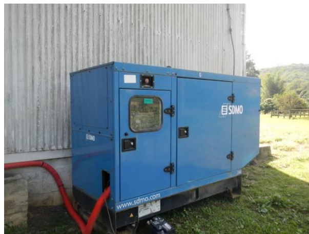
Figure 20 : Groupe électrogène 80 KVA - Photo Soproner
