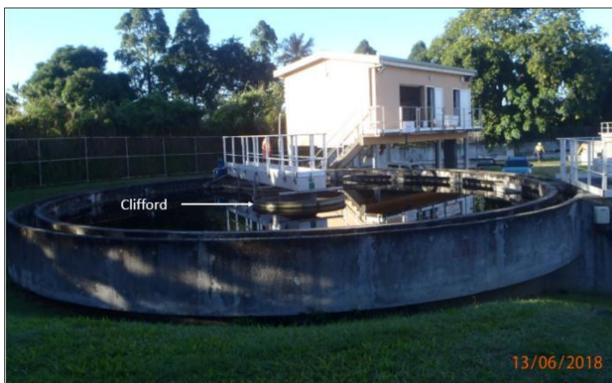
Figure 13 : Clarificateur de la STEP de Yahoué -file 3500 EH – Source : EMR, 2018
