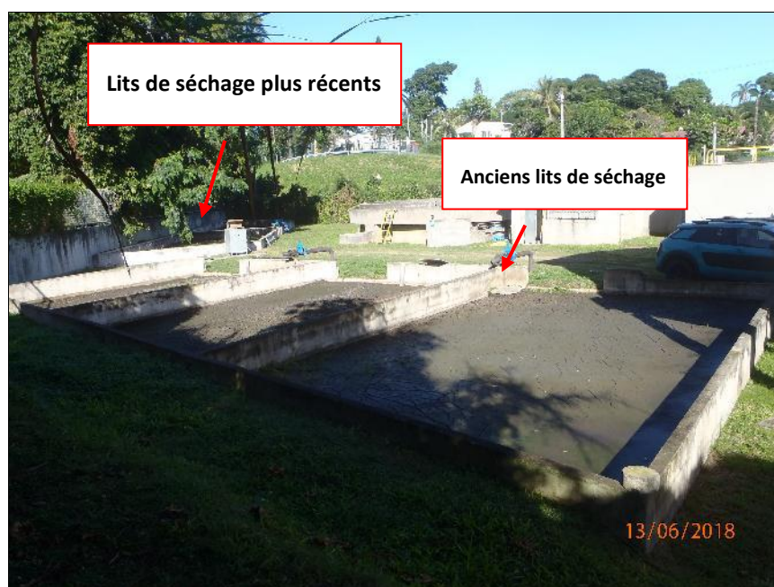
Figure 17 : Lits de séchage de la STEP de Yahoué – Source : EMR, 2018
