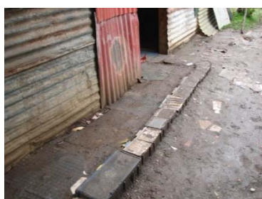
Seuil de porte en accumulateurs au plomb
