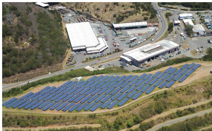
Figure 50 : Panneaux photovoltaïques, sur le site réhabilité de l'ancienne décharge, source Ville de Nouméa
