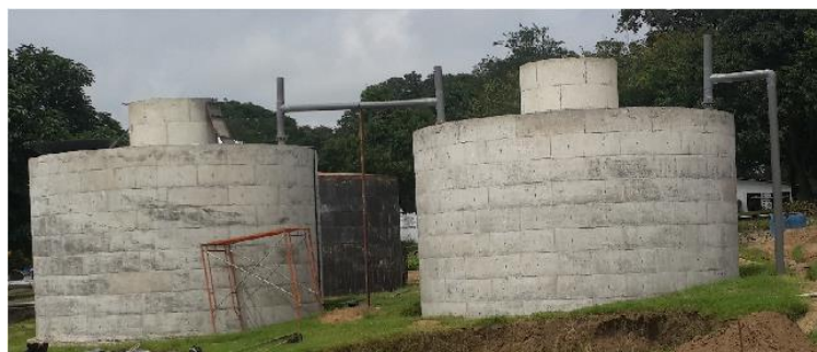
Figure 39 : Digesteur béton ou couverture flottante sur fosse existante
