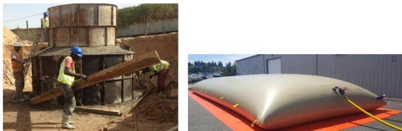
Figure 41 : Construction digesteur de 10 m 3 / Digesteur souple
