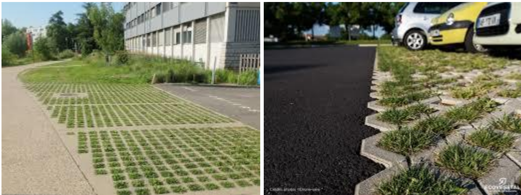
Figure 47 : Exemple de parkings en dalles béton avec remplissage végétal
