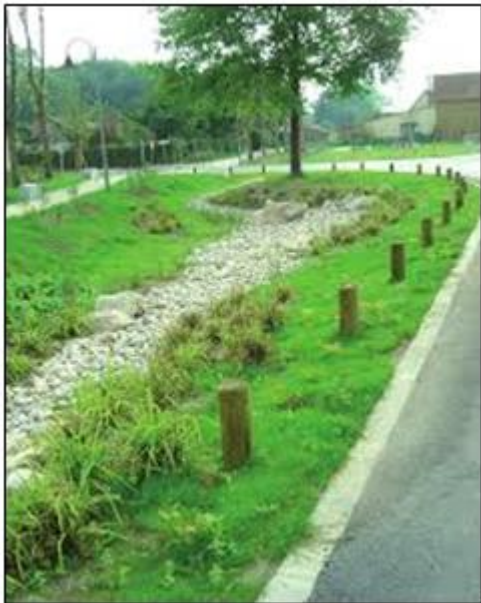
Figure 46 : Exemple de noues paysagères (Source : ETIK, APS mars 2020)
