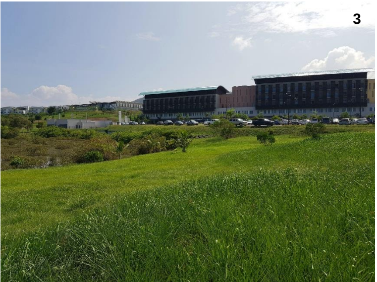
En direction du centre hospitalier
