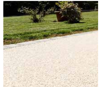
CHEMINEMENT PIÉTON EN BÉTON OU TYPE HYDROWAY - RÉSINÉO : PERMÉABLE
