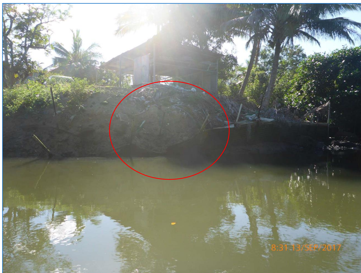
Figure 4: Effondrement du mur en rondins en aval du tronçon Ouap_02 - Source: EMR, 2017.
