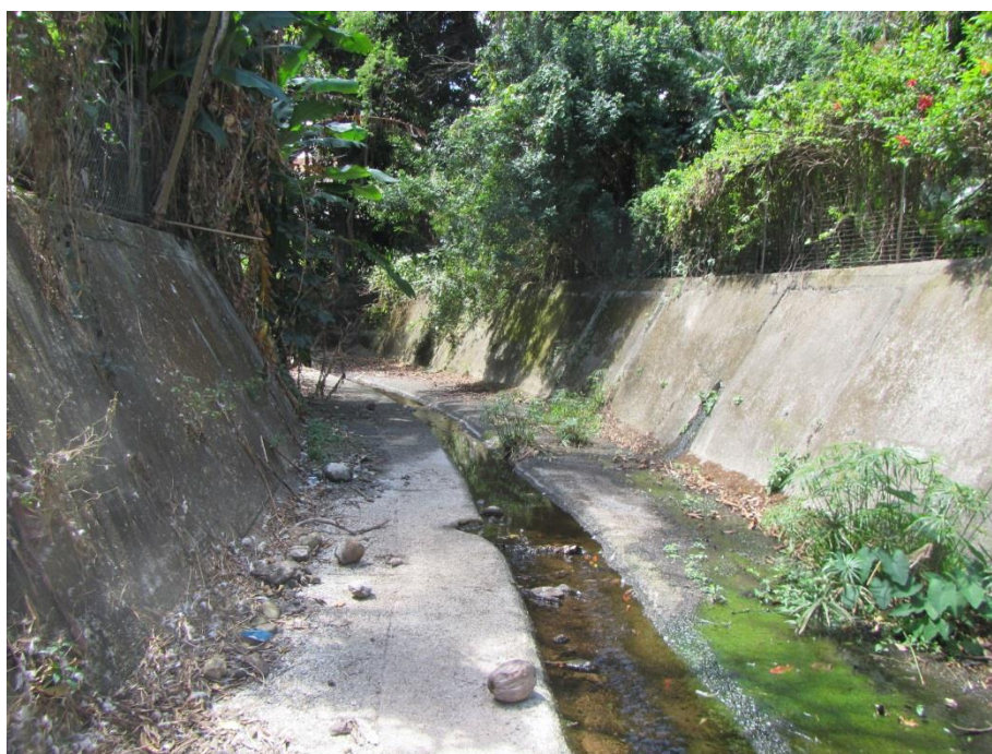
Figure 19 : Yanna, section bétonnée
