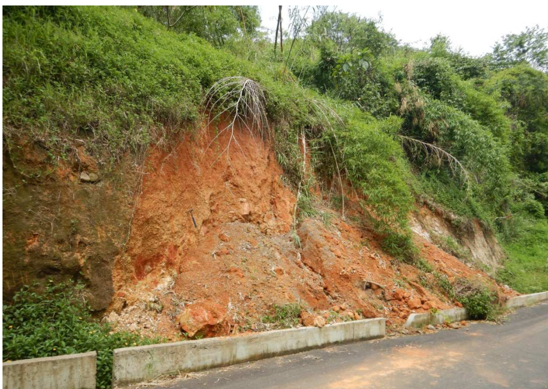
illustration 11 – Instabilité d'un talus routier dans des siltites charbonneuse du Jurassique entièrement argilitisées (Gohapin, Poya)
