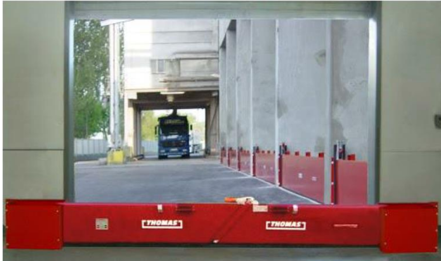
Figure 6 : Type de barrière passive amovible prévue sur le site RECY'GEM
