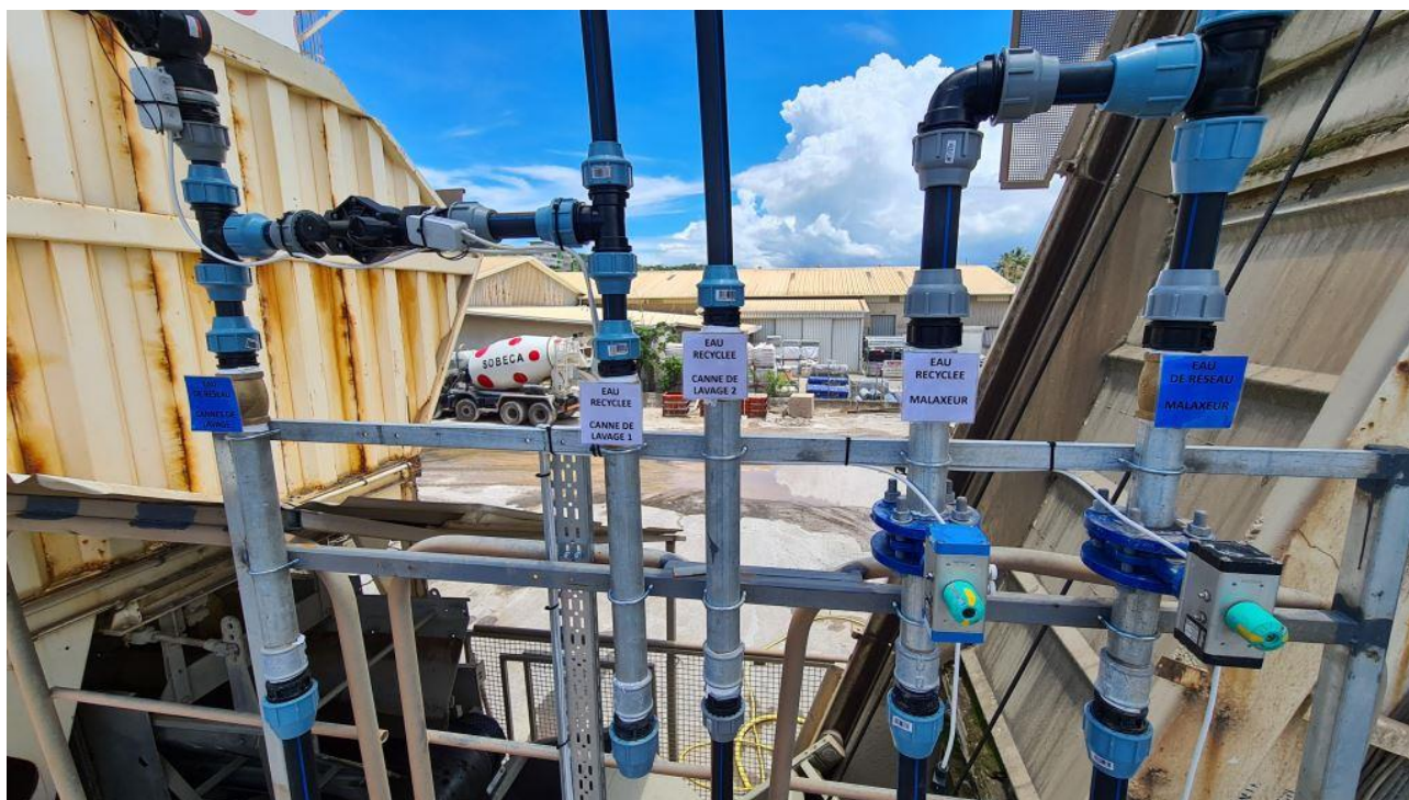
Figure 17 : Jeu de vannes de la centrale à béton qui privilégie l'utilisation de l'eau de process recyclée
