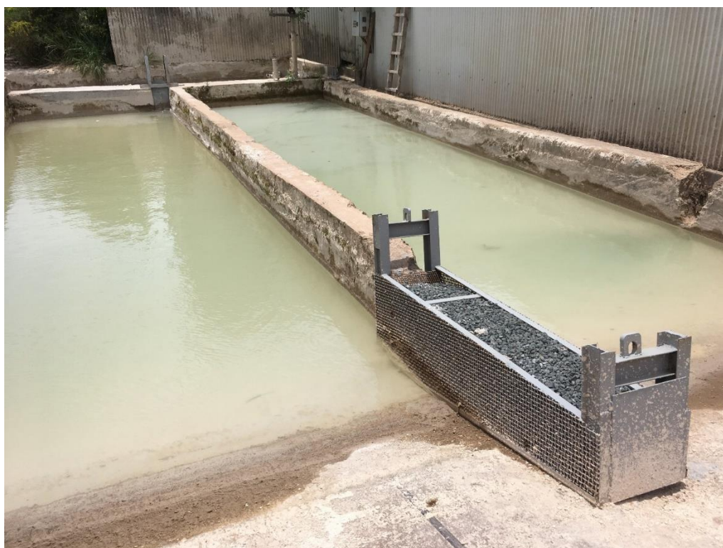
Figure 18 : Vues du système de filtration/décantation des eaux de ruissellement propre au secteur de la centrale à béton – Système actuellement en place sur Ducos
