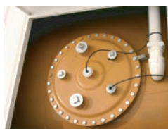
Trappe d'accès trou d'homme de cuve
