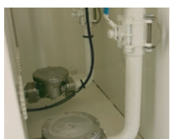
Vanne d'isolement DN40 - Clapet anti-siphon LAFON
