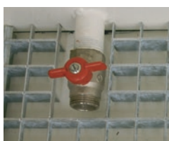
Purge bac de rétention - Caillebotis anti-dérivant
