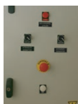
Coffret électrique IP 54
