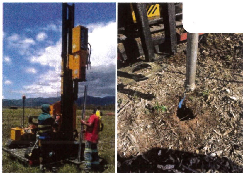
Mise en place du pieu battu avant battage(gauche) et Marteau à fond de trou (droite), Machine Orteco 800 HD
