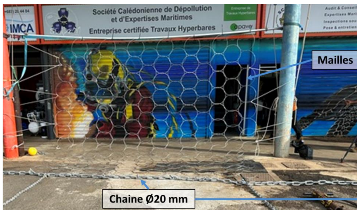
Figure 2 : Photographie de la barrière en cours de réalisation
