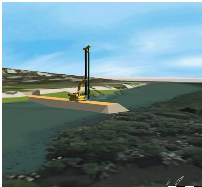
Figure 19 : Phase Travaux – passerelle P2
