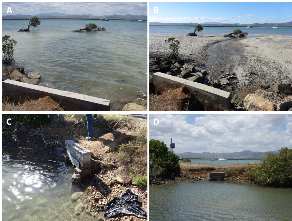
Figure 8 : Buse unique traversant la route et permettant les échanges entre la lagune et le lagon, A- ouverture coté lagon (marée haute), B - ouverture côté lagon (marée basse), C - ouverture côté lagune, D - vue générale côté lagune.
