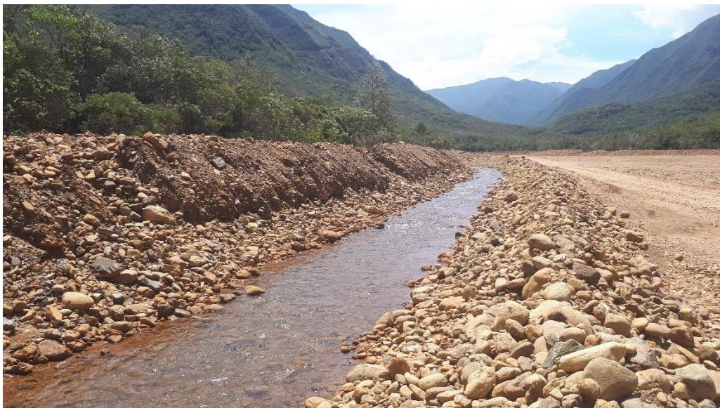
**Figure 7 : Photographie d'une zone exploitée avec protection des berges et distanciation vis-à-vis du cours d'eau**
