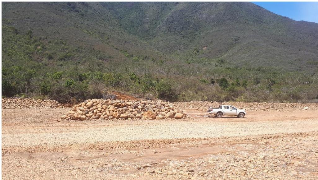
**Figure 8 : Photographie de la mise en protection d'un piézomètre utilisé pour le suivi de la qualité des eaux à l'aval des zones d'extraction.**
