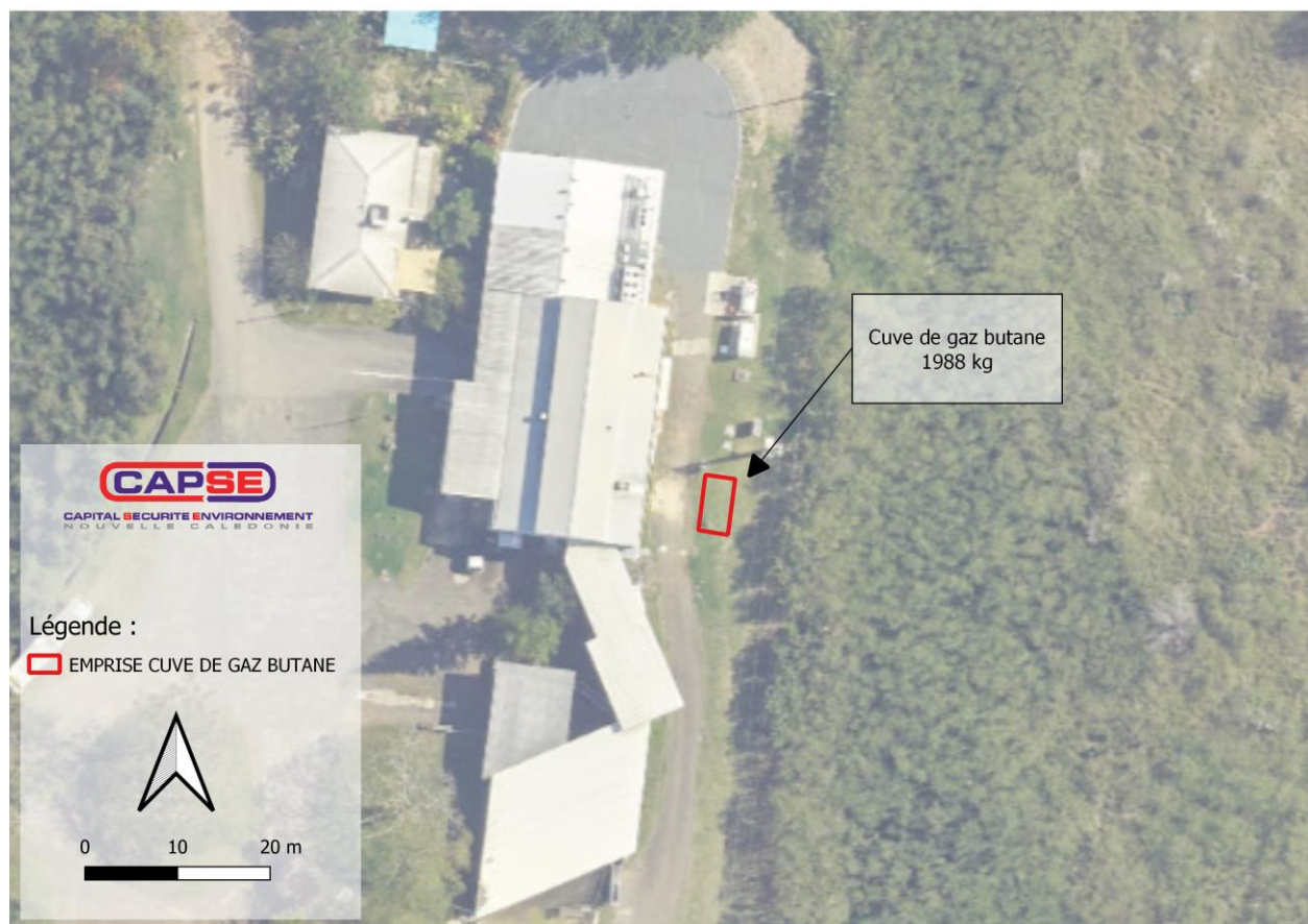
Figure 10: Localisation de la cuve de gaz fixe aérien, source : Géorep, CAPSE NC
