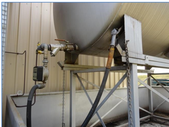
Vanne d'arrivée extérieure
