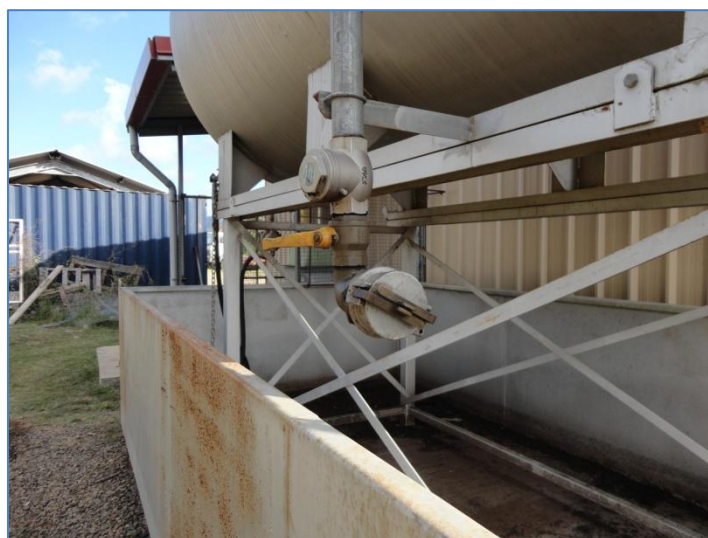
Figure 16 : Raccord de dépotage
