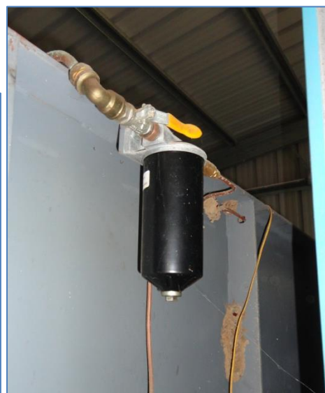
Vanne d'arrivée intérieure
