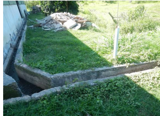
Figure 55 : Vanne pour évacuation des eaux de lavage et rigole bétonnée vers la fosse
