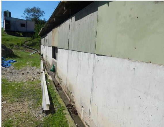
Figure 20 : Vanne pour évacuation des eaux de lavage et rigole bétonnée vers la fosse
