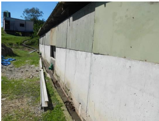
Figure 55 : Vanne pour évacuation des eaux de lavage et rigole bétonnée vers la fosse
