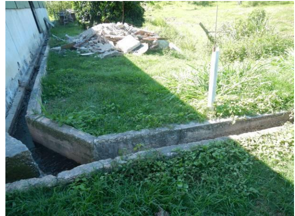
Figure 20 : Vanne pour évacuation des eaux de lavage et rigole bétonnée vers la fosse
