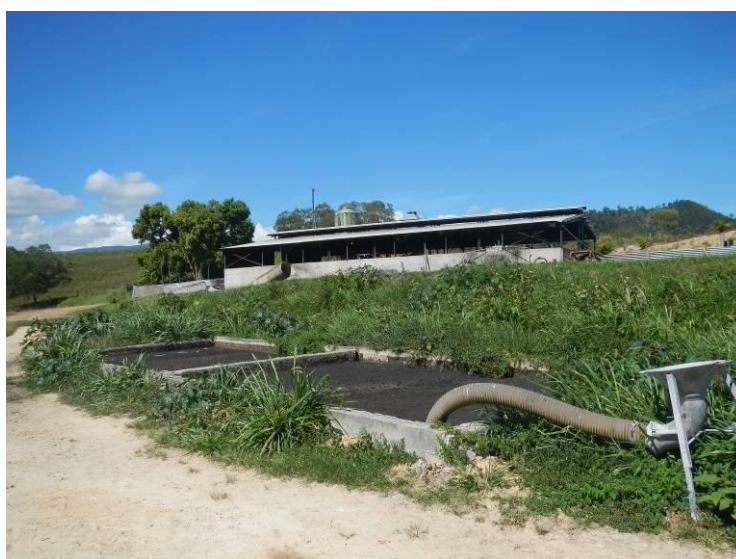
Figure 18 : 2 Fosses bétonnées : Zone des 2 bâtiments d'Engraissement – volume environ 80 m3 au total
