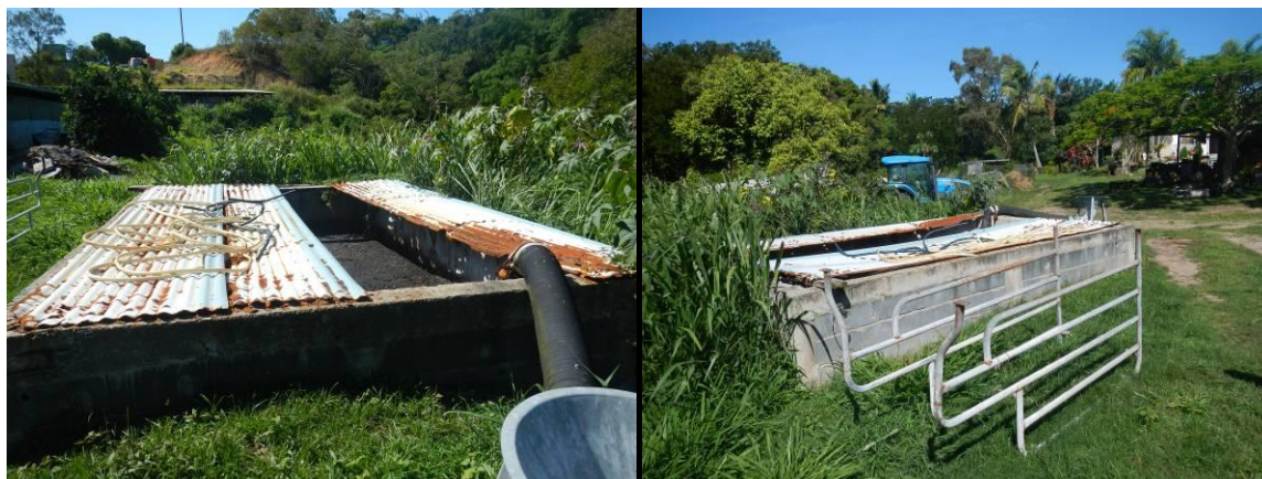
Figure 17 : Fosse bétonnée – Zone bâtiment Maternité, Post-Sevrage et Gestation/Verraterie – volume : env 48 m3
