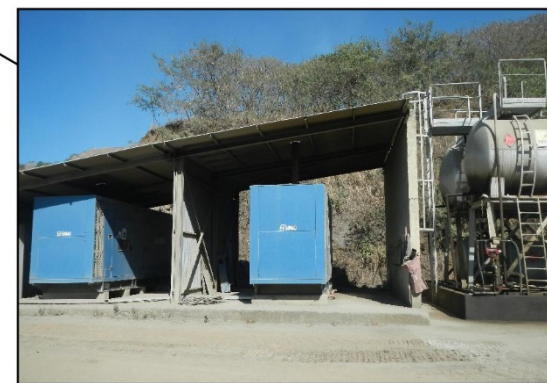
Groupes électrogènes et cuves de carburant
